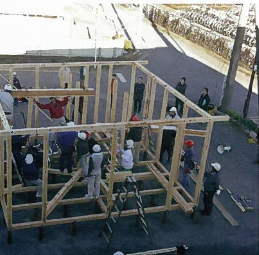
重機や足場を使わない建て方作業(29日、東京都羽村市)
